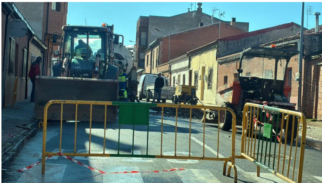
Trabajos en una de las calles afectadas // Foto cedida
