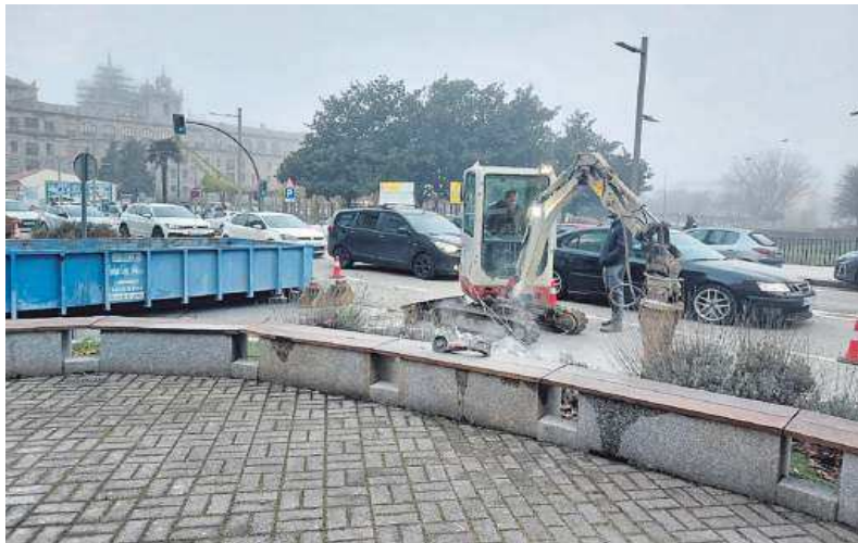
Obras para la reparación de la avería que motivó un corte de agua la pasada Nochebuena. F. ALBO
